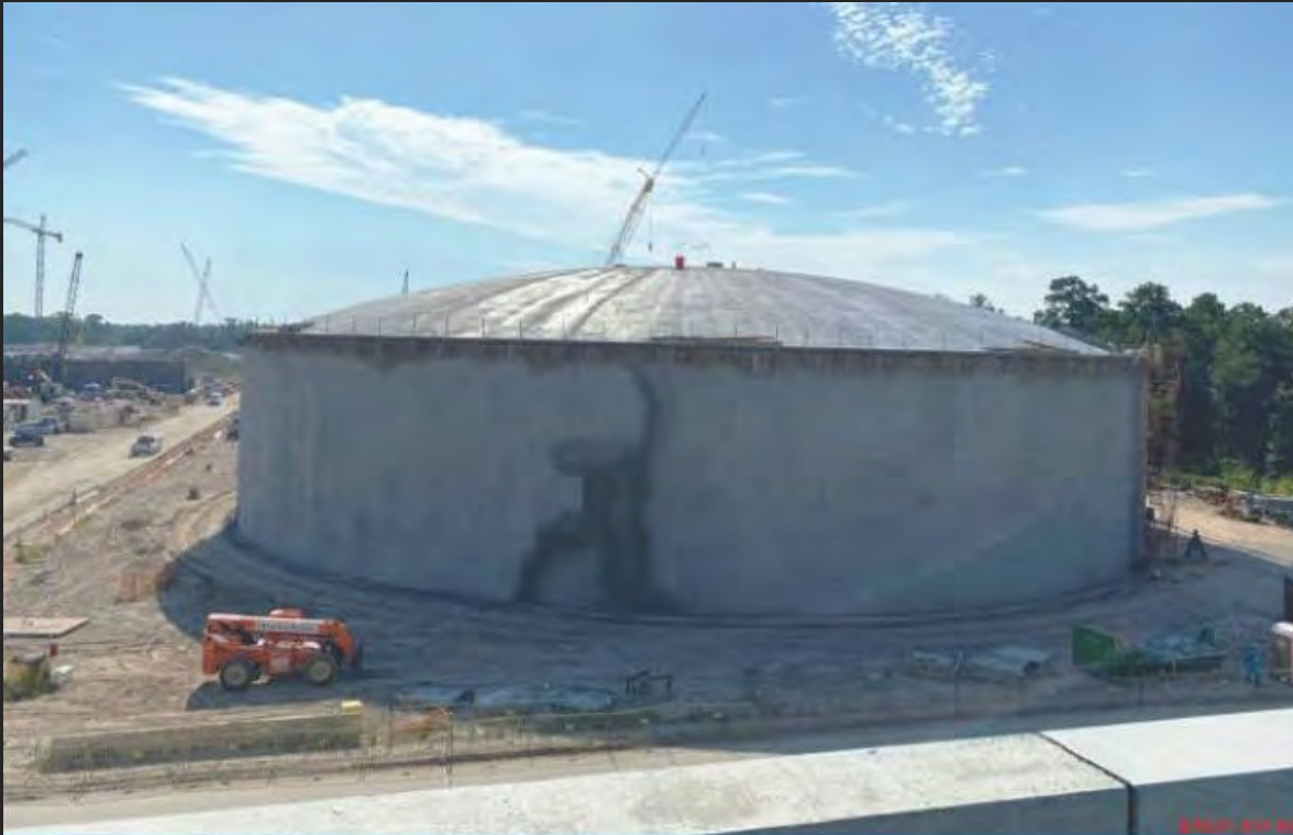
Completed Dome Pour GST 361
